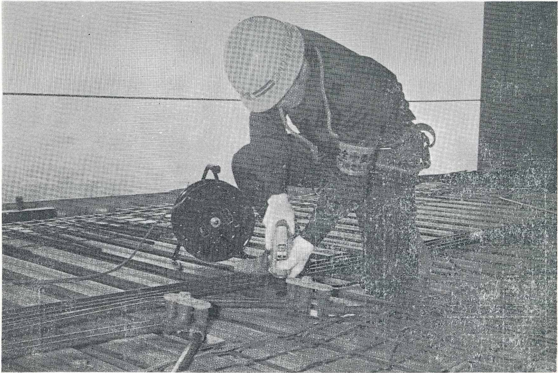
金属製の電線管用エンドエルボを使用した配管工事
