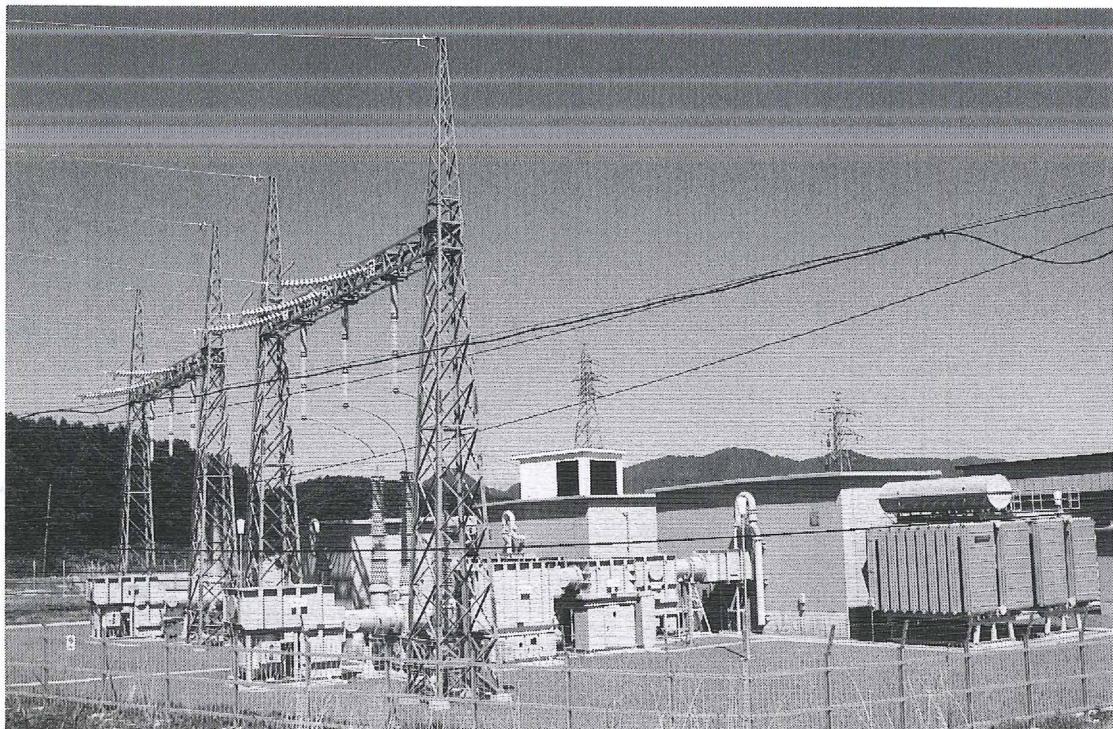
青函トンネル吉岡変電所 き電用変圧器 187/40KV×80000KVA×1 40/20KV×10000KVA×2
