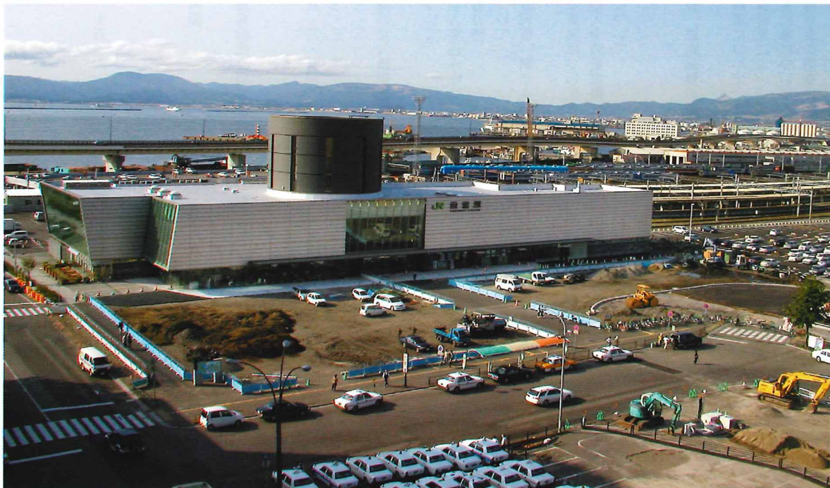
新装函館駅と工事中の駅前広場
