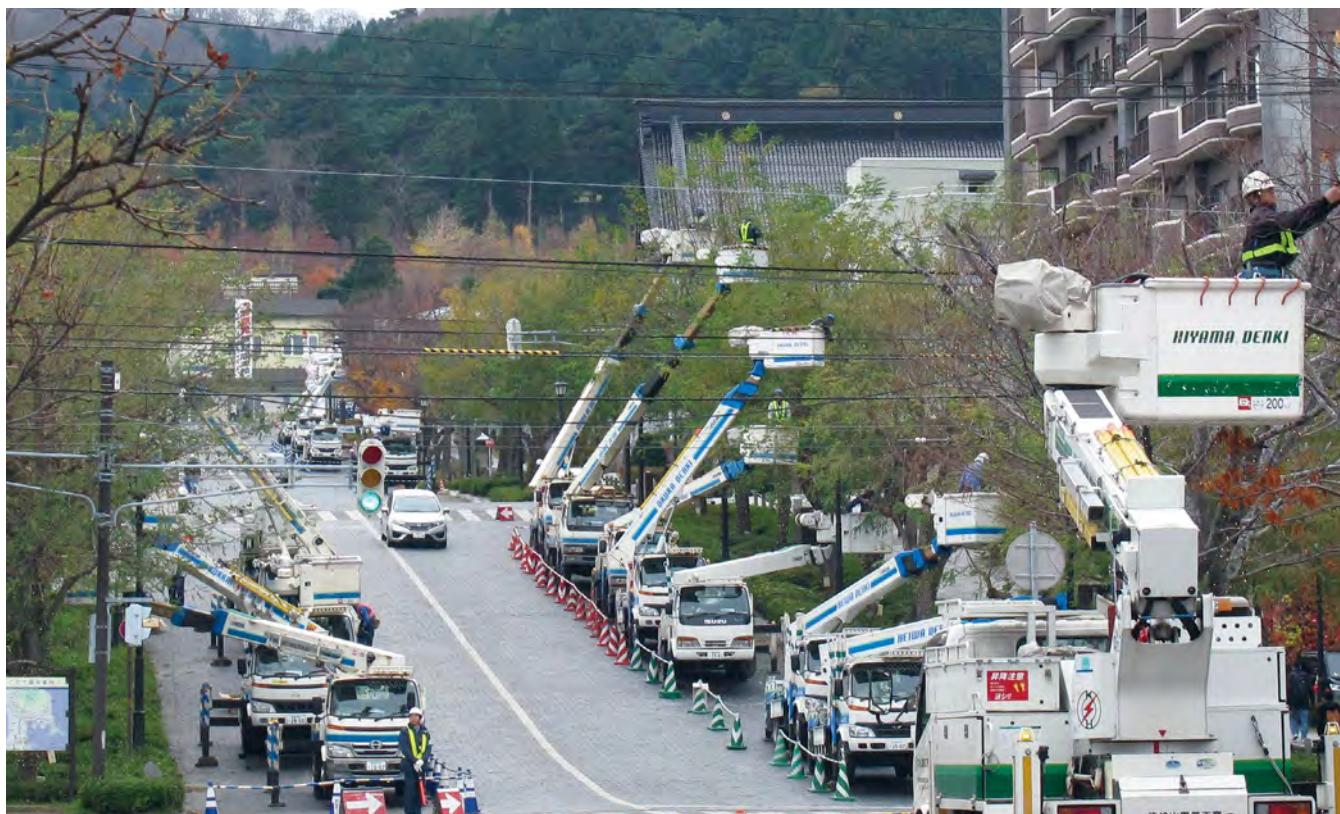
二十間坂に二十九台の高所作業車が集結したイルミネーション取付工事（平成二十六年十一月九日）
